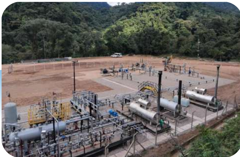
Fotografía: Instalación de Líneas y Facilidades de Producción Churumas
